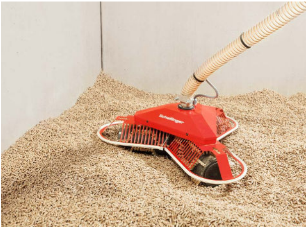
Lagerraum mit Zuführung zum Pelletkessel durch Maulwurf-System
